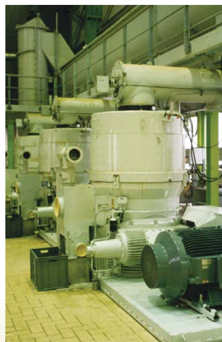
Современная станция фильтрпрессов на сахарном заводе
