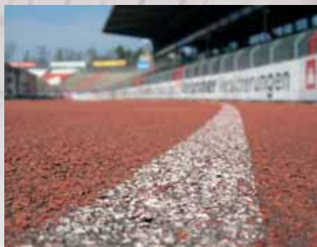
Использование крупки из старых покрышек в спортивных сооружениях позволяет сберечь людей и материал.
