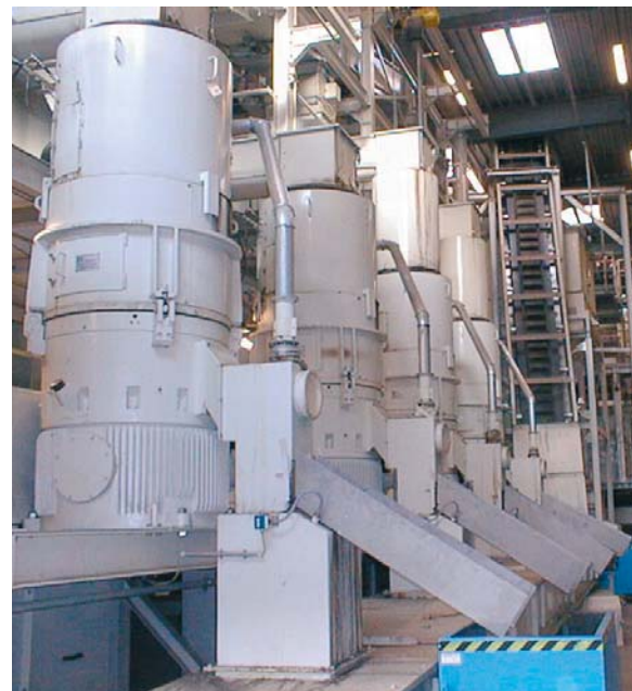
Прессы-грануляторы в линии гранулирования бытового мусора
